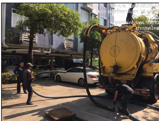
ภาพที่ 8-11 เจ้าหน้าที่สูบลากตะกอน และ สูบอัดก๊าซ
