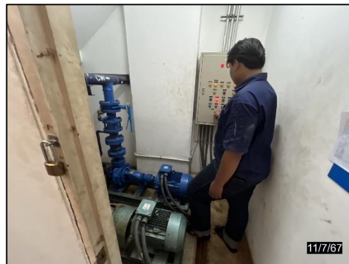
ภาพที่ 92-93 ตรวจสอบปั้มน้ำจากถังเก็บน้ำชั้นใต้ดินไปยังถังเก็บน้ำชั้นดาดฟ้า
